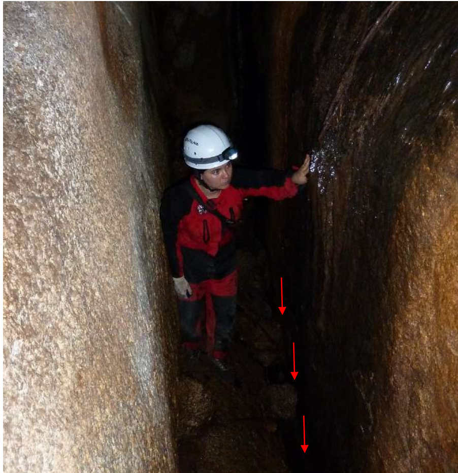
Figura 5.9 – Galeria estreita, mas com altura suficiente para andar em pé. À direita no piso (indicada pelas setas) há uma fenda com cerca de 2 m de profundidade e menos de 50 cm de largura por onde a água escorre e desaparece.
