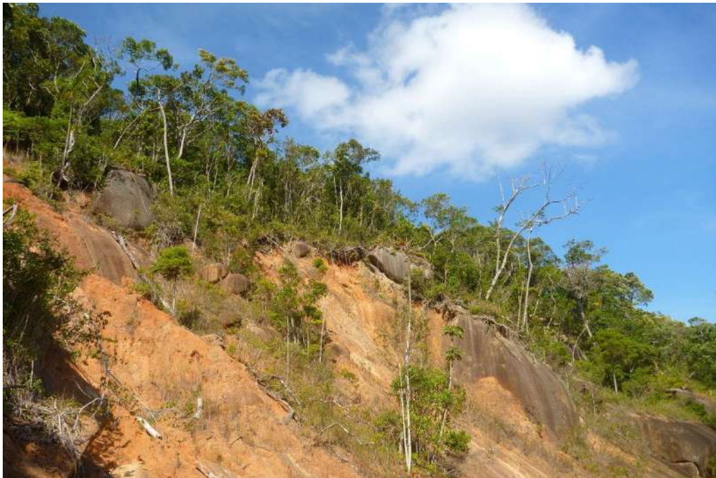
Figura 5.2 - Exposição do maciço rochoso e de matações do Granito Ilha em antiga área de extração da rocha a montante do SAC.
