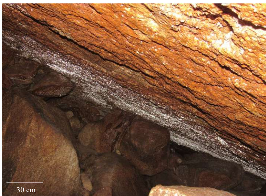
Figura 6.86 – Teto da Gruta das Feiticeiras colonizado por fungos e possivelmente líquens (porção esbranquiçada).
