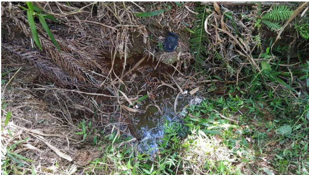
Figura 5.52 – Ponto onde os cursos d'água A e B ressurgem em superfície, já na área externa ao SAC (lateral direita de montante para jusante).
