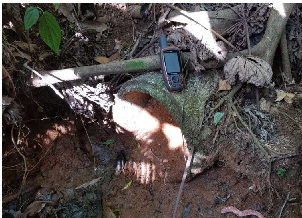
Figura 5.51 – Ponto um pouco a jusante de onde o curso d'água A deixa o SAC, infiltrando-se em material da unidade Depósitos Colúvio-aluvionares. Durante as obras do loteamento Jardim Recanto da Ilha houve uma tentativa de canalizar a drenagem, que com o tempo foi obstruída por sedimentos, o que teria induzido o curso d'água a assumir um novo percurso subterrâneo.
