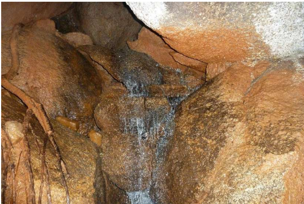
Figura 5.53 – Marcas no piso e paredes que delimitam o curso d'água A, definidas por variação de coloração e fixação de carga sedimentar (incluindo matéria orgânica), mostrando as variações no nível e intensidade do fluxo de água.
